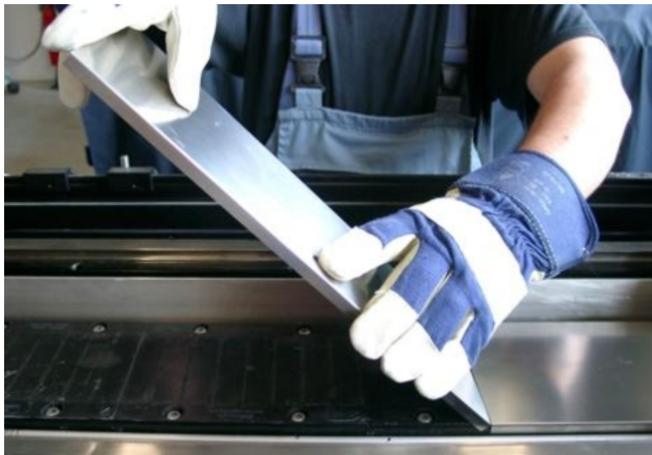
图 5-27 分段式盖板上下一段盖板的安装
